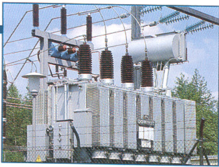
Bild 1: Großtransformatoren in Umspannwerken sind eine leistungsfähige Quelle vor allem magnetischer Felder.
