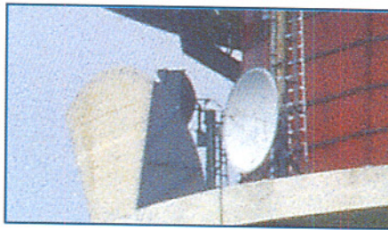
Bild 2: Gefahr nur für Techniker, die daran arbeiten: Richtfunkantennen strahlen sehr gerichtete Energie in sehr hohen Frequenzbereichen ab. Hier wirkt im (Un-)Fall vor allem der thermische Effekt.
